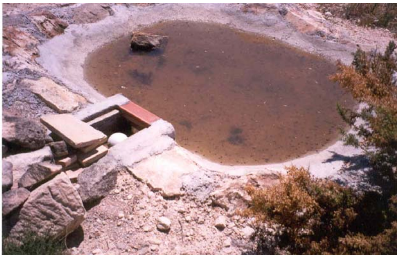
Foto nº8: Tant els banys interiors com els exteriors s'autoabasteixen d'aigua mitjançant un sistema de boies.
